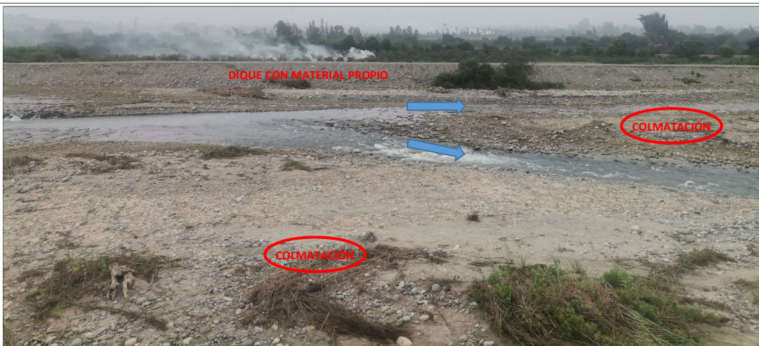
FIGURA N°03: DIQUE EXISTENTE DE MATERIAL PROPIO EN MAL ESTADO EN EL MARGEN IZQUIERDO DEL RIO CHANCAY - HUARAL, ZONA VULNERABLE EN EPOCAS DE AVENIDAS.
