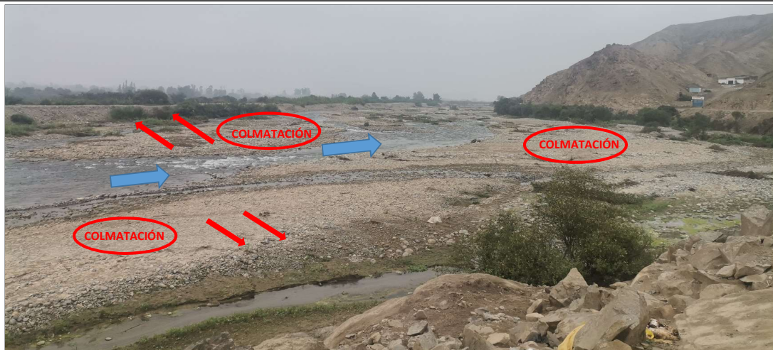
FIGURA N°02: TRAMOS EN EL MARGEN IZQUIERDO DEL RIO CHANCAY - HUARAL CON DEFENSA VIVA Y MATERIAL GRANULAR SUELTO, OCASIONA QUE EL DESBORDAMIENTO DEL CAUCE DEL RIO SEA MAS INMINENTE EN EPOCAS DE AVENIDAS.
